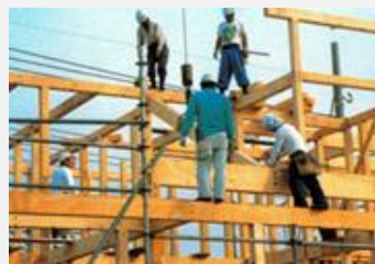
金属接合材のハイブリット構造 木造軸組ハイフレ임構造
