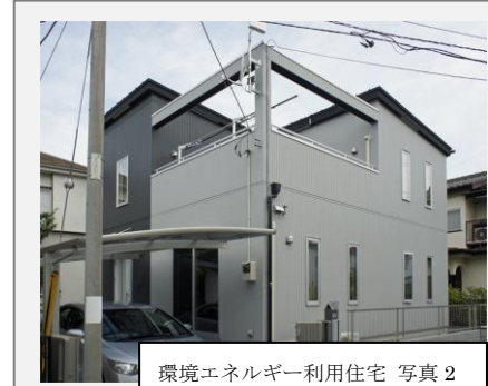
環境エネルギー利用住宅 写真 2
