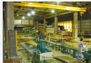
高品質を裏付けるプレカット工程
