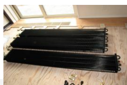
写真は床下に入れる暖房器具等
