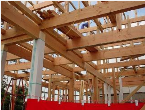
長尺物の梁材を使用した事例
