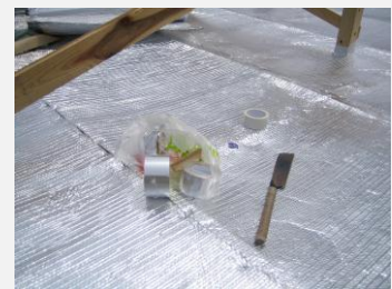
遮熱シート (野田村応急仮設住宅)
