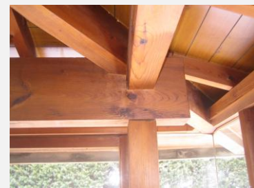
伝統的な柱と梁の接合部（仕口）
