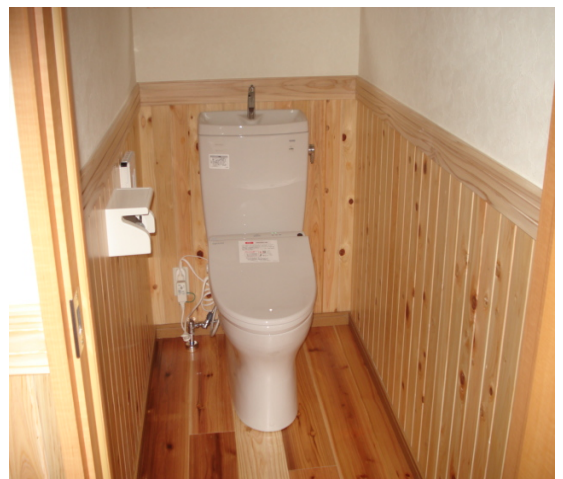
腰壁に杉板を使ったトイレ。杉材は製作所にて加工
