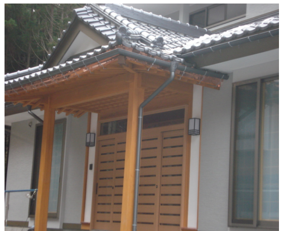
杉板使用の玄関ポーチ
